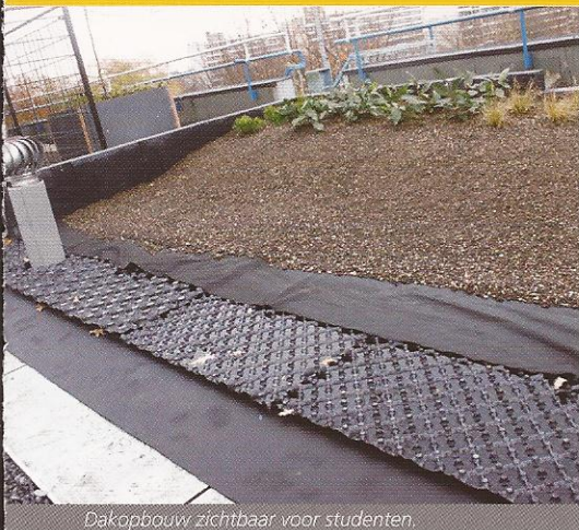
Dakopbouw zichtbaar voor studenten.
